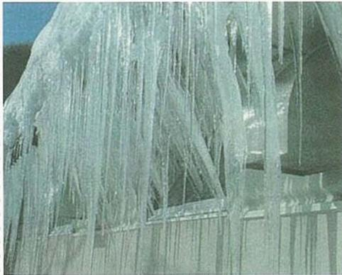
また、屋根に積もった雪がせり出し、垂れ下がった雪庇(せっぴ)を形成し、その先にはツララが発生します。このケースでは雨樋の破損の他、窓ガラス等の損傷が発生し、ツララを伴った落雪が起こった場合は人的な被害が発生する恐れがあります。
