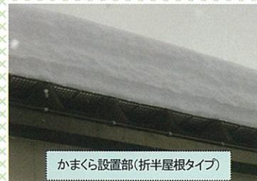
かまくら未設置の場合はツララが発生しているのに対し、かまくら設置部においてはツララが発生していない。これは、かまくら部分から融雪水分が排出され含水率が低下しツララが発生しにくい状況にあるといえ、上記理論を裏付ける結果といえます。
