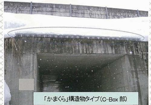
「かまくら」部で雪を受け止めているため、雪庇(せっぴ)の垂れ下がり(巻き込み)を防止していますので雨樋などの破損がなく、排水効果によりツララも発生しにくくなります。
