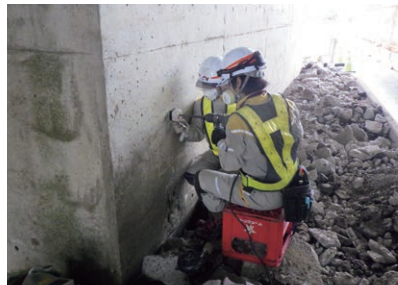
ハンマードリルによる試料採取 構造物より分析用の粉末試料採取を行います。
