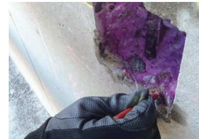
中性化試験 コンクリート表面からの中性化深さを測定します。
