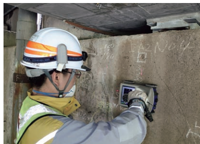
鉄筋探査 構造物表面より鉄筋の位置を計測します。
