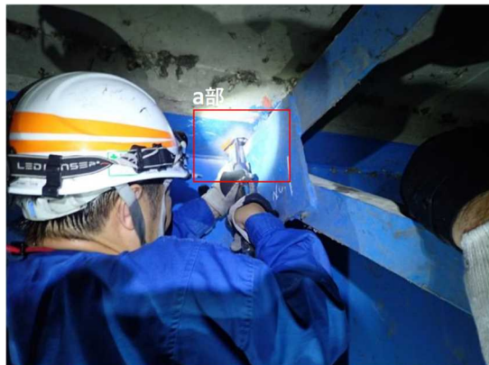
ICR 施工状況
