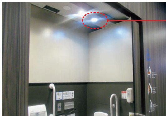
ブース内の忘れ物をアウトラインセンサーの撮像素子による検知で通知
