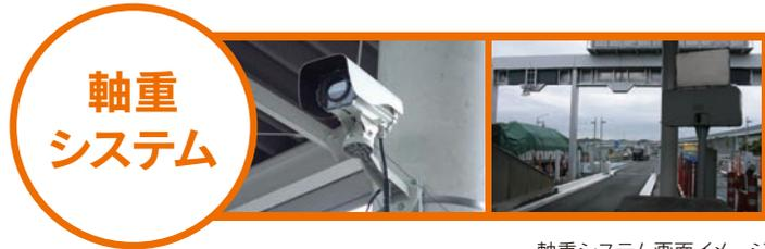
軸重計と車両認識システムを突合せすることで、通過した車両が軸重超過車両の判別を実施、ナンバー情報を履歴に残すことができます。
